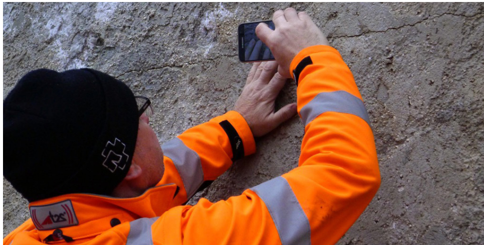
Inspecter une fissure. © Jérôme Denis
